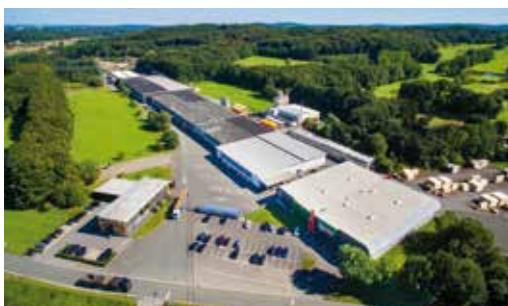
Production Site Westerkappeln
