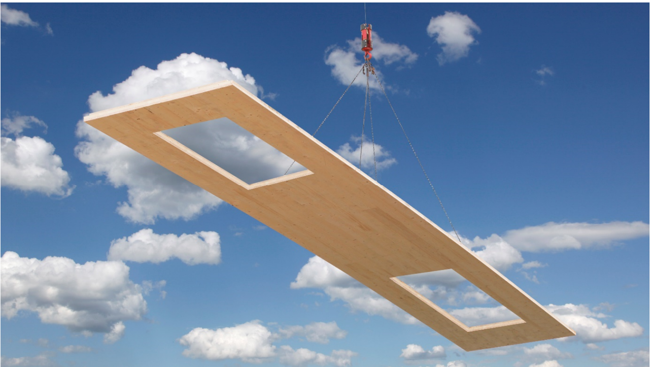
X-LAM Bauteil bei der Montage auf der Baustelle
