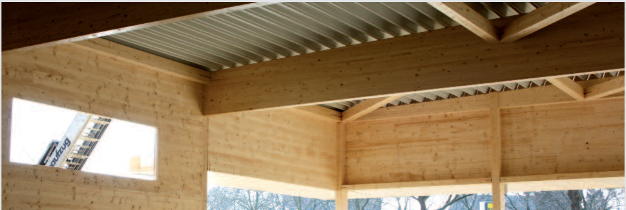
Eine rasche Dacheindeckung schützt sichtbare Oberflächen optimal vor Witterungseinflüssen.
