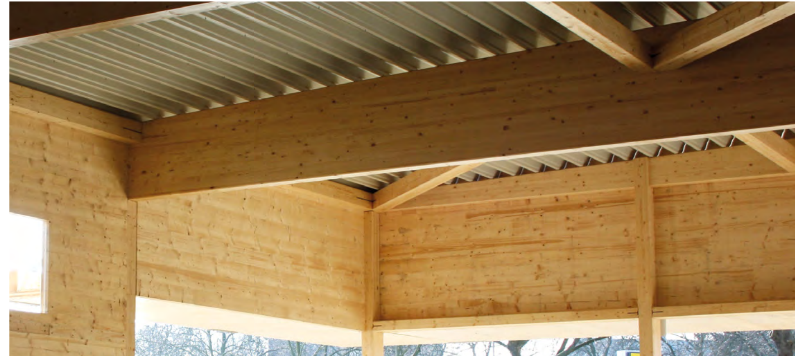
Eine rasche Dacheindeckung schützt sichtbare Oberflächen optimal vor Witterungseinflüssen.
