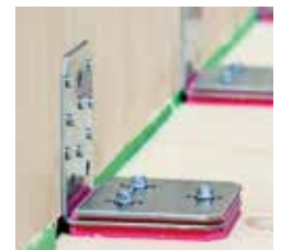
Einglassener Stoß, Vollgewindeschrauben senkrecht von außen
