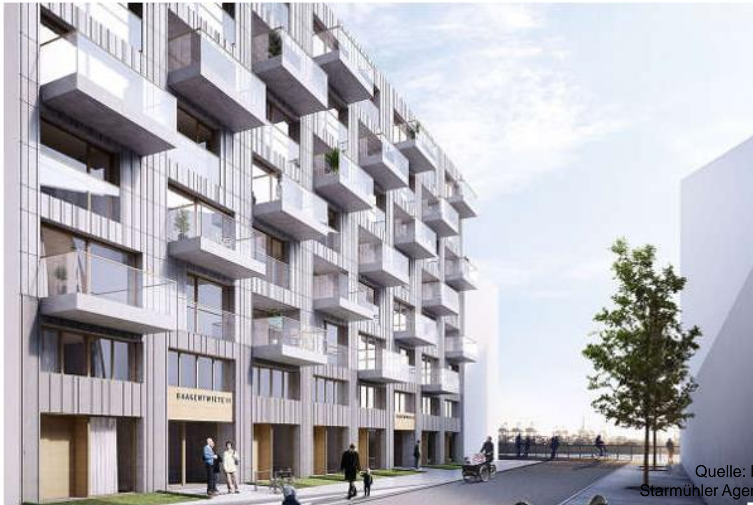
Auf den zweistöckigen Betonsockel werden sechs Holzgeschosse aufgesetzt. Foto: Kaden+Lager
