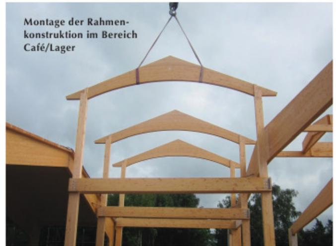
**Montage der Rahmenkonstruktion im Bereich Café/Lager**
