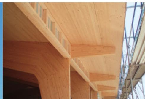
**Dreigelenkrahmen mit Beihölzern für die Dachüberstände. In den Bindern befinden sich bereits werksseitig eingebrachte Bohrungen und Einfräsungen für Kabelstränge und Lichtleisten**
