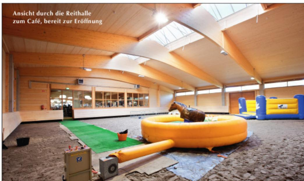
140 mm. Somit bestehen nahezu sämtliche konstruktiven Teile des Gebäudekomplexes aus Holz. In der Reithalle sind lediglich deshalb Stahlbetonstützen und eine umlaufende 80 cm hohe Aufmauerung notwendig geworden, weil der dortige Sandboden eine permanent erhöhte Feuchtelast darstellt.
