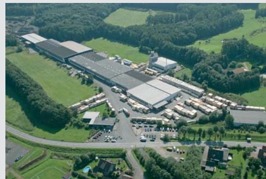
Production plant, Westerkappeln
