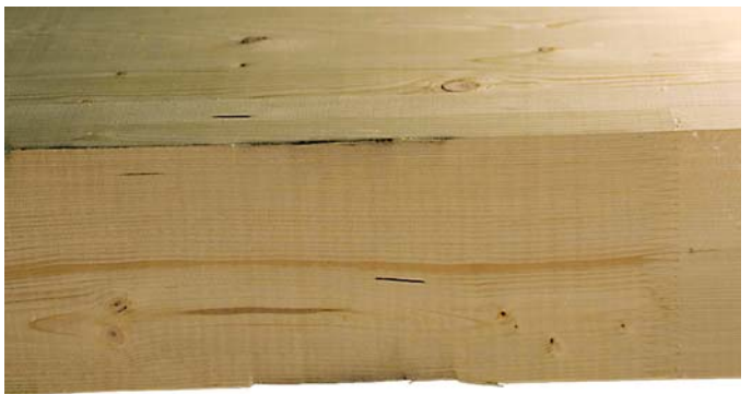
Bild 13a, b Hebevorgang; un- zulässige Eindrückung durch Gurte
