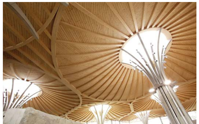
Bild 2 Dachkonstruktion Elefantenhaus Zoo Köln
