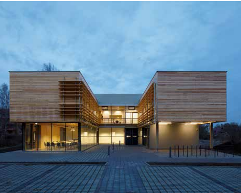
Abb. 15: Frontalansicht des Forstamts Jena-Holzland in Stadtroda
