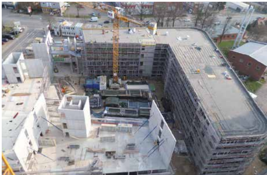
Abb. 27: Brandwände und Treppenhaukerne in Stahlbeton
