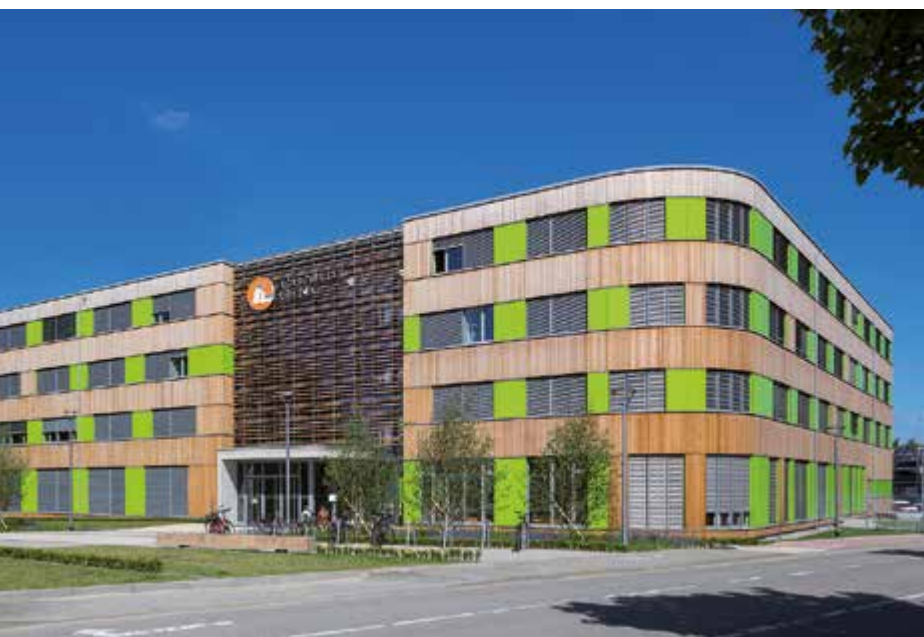
Abb. 25: Aussenansicht der Stadtwerke Lübeck
