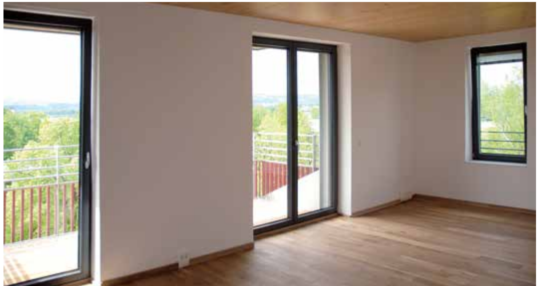
Abb. 40 Innenansicht mit sichtbarer Brettsper Holzdecke
