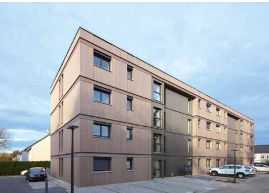
Abb. 20: Gebäudevorderseite mit Holz- fassade. In Deckenebene sind die Brandsperren erkennbar
