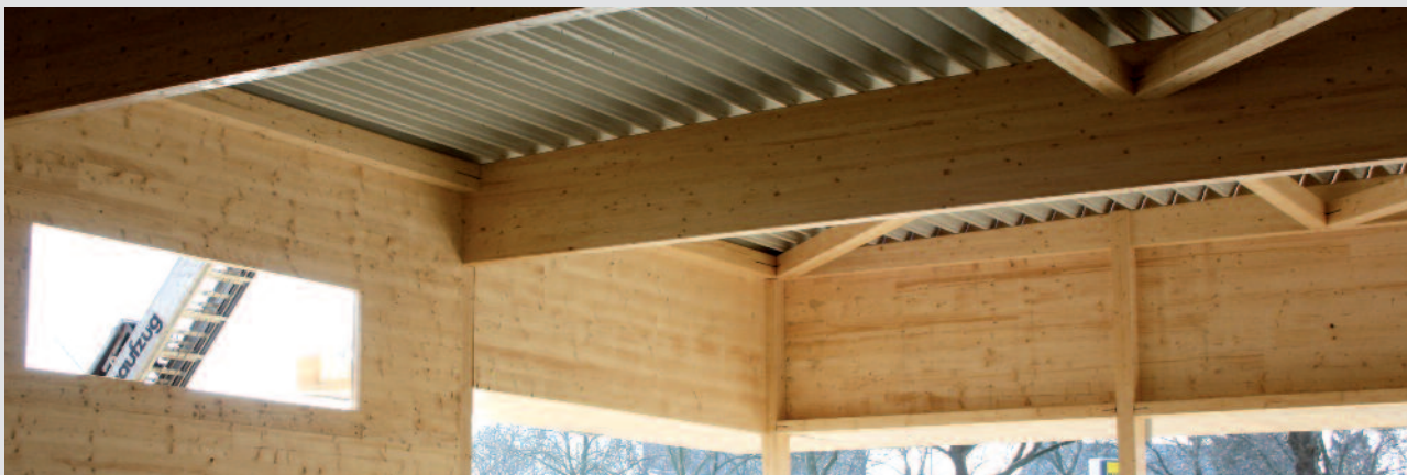
Une couverture rapide du toit protège parfaitement les surfaces visibles contre les influences climatiques.
